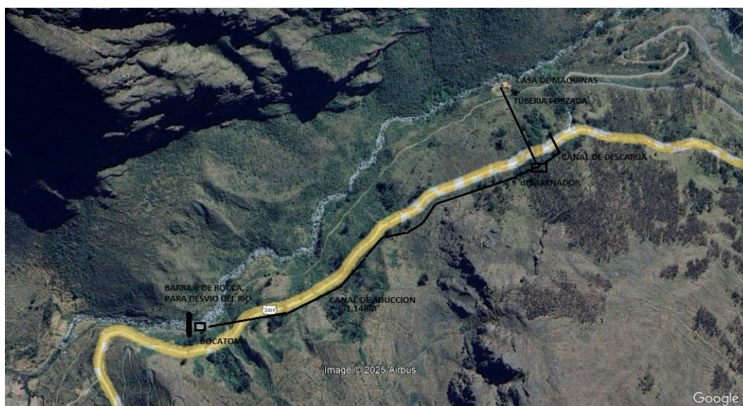
Figura 5 - Obras del MCH 2, con las dimensiones básicas identificadas en el aprovechamiento
