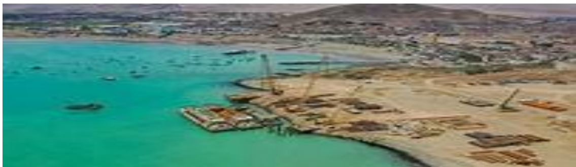
Fig. 1 Chancay: El Pacífico con un terreno de grúas durante su construcción
