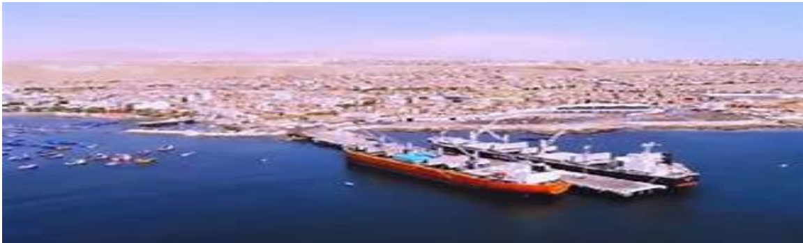
Fig. 4 Terminal portuario multipropósito que dinamizará la economía regional
